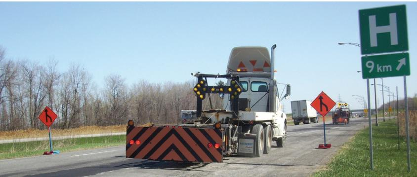
Installer la barrière et la flèche de signalisation toujours selon les dessins normalisés TCD 093 et TCD 020 du Tome V, comme indiqué sur le schéma 9.
