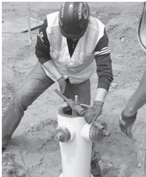
**Étape 9.** Retirez le mécanisme intérieur de la borne d'incendie.
