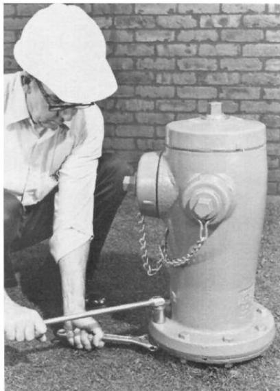
1. Desserrez les écrous sur les boulons de bride de sécurité.
