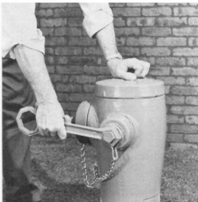
1. Dévissez et retirez le capuchon de la buse. À l'aide d'un outil pointu ou d'un poinçon, retirez le verrou de buse. Si la buse est
