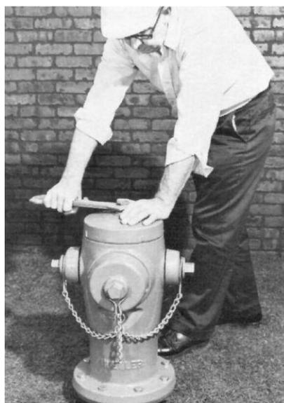
4. Serrez l'écrou de commande en le tournant dans le sens de la fermeture.
