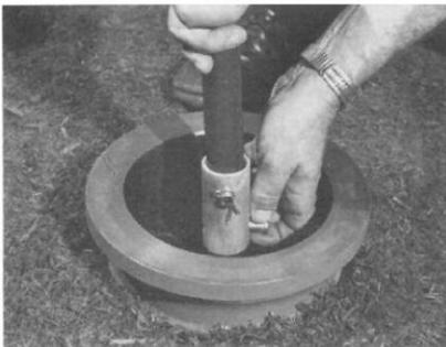
3. Retirez le canon supérieur et retirez la tige et l'accouplement de tige de sécurité en retirant la goupille fendue et l'axe de chape inférieurs en acier inoxydable.
