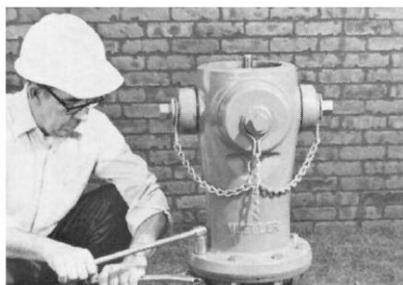
7. Fixez le tube supérieur au tube d'extension avec les moitiés de la bride de sécurité (avec le biseau sur le bord extérieur vers le bas) et les boulons, en vous assurant que le joint de la bride de sécurité est en place.
