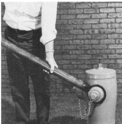
3. Fixez une longueur de tuyau sur l'extrémité de la poignée de la clé et dévissez la buse.
