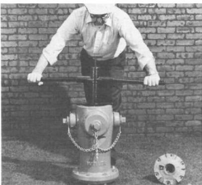
2. Faites glisser l'extrémité fendue de la clé sur le dessus de la tige et engagez la fente avec la goupille soudée à la tige supérieure. Serrez fermement la poignée en « T » de la clé. Abaissez le bras de support sur le dessus du canon supérieur et serrez la vis moletée pour maintenir la vanne principale en position fermée. Fermez l'eau au robinet-vanne. Retirez l'assemblage de la vanne principale en tournant la clé du siège dans le sens antihoraire.
