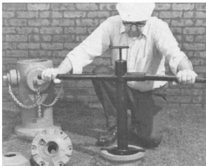
3. Retirez l'ensemble de la vanne principale en tournant la clé dans le sens antihoraire et retirez la clé, la tige inférieure, l'ensemble de la vanne principale et l'anneau de siège du barillet de la bouche d'incendie en tant qu'unité.
