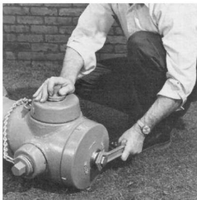
1. Serrez l'écrou de fonctionnement pour vous assurer que la vanne principale est en position complètement FERMÉE.
