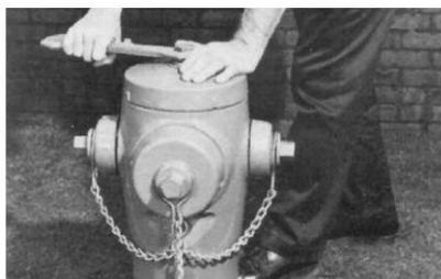
9. Dévissez légèrement un capuchon de buse de tuyau pour purger l'air. Ouvrez complètement la bouche d'incendie. Serrez le capuchon de la buse du tuyau lorsque l'eau commence à couler et vérifiez que tous les joints ne fuient pas. Tournez l'écrou de fonctionnement en position complètement fermée et retirez le capuchon de la buse du tuyau pour permettre au baril de se vider. Remplacez le capuchon de la buse du tuyau.
