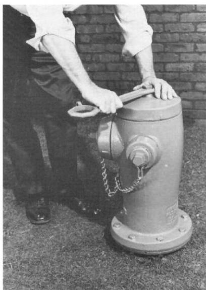
2. Tourner légèrement l'écrou de commande dans le sens de l'ouverture pour soulager la compression entre les sections du cylindre.
