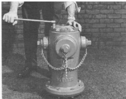
1. Retirez le capuchon étanche, l'écrou de retenue, l'écrou de fonctionnement et la rondelle anti-friction. Lubrifiez le manchon en laiton et faites-le glisser sur l'extrémité de la tige filetée pour éviter d'endommager le joint torique. Déboulonnez et retirez le boîtier. Retirez le manchon en laiton.
