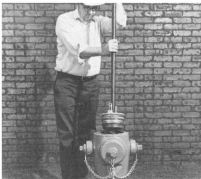
6. Abaissez la vanne principale dans le canon, tournez la clé de siège dans le sens des aiguilles d'une montre et vissez soigneusement la vanne principale et la bague du siège dans la base de la bouche d'incendie en serrant à la main. Soulevez la soupape principale en laissant environ 1/2 po de jeu entre la soupape principale et le siège. Abaissez le bras de support et serrez la vis moletée.
