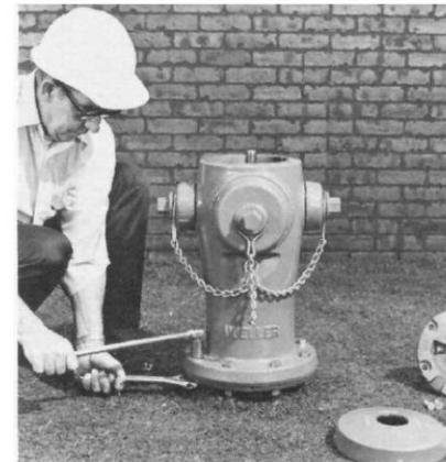
6. Placez le joint de bride sur la bride exposée du canon inférieur. Placez soigneusement le canon supérieur en position sur le canon inférieur. Assurez-vous qu'il est concentrique avec le canon inférieur et que le joint est centré. Boulonnez en place les deux moitiés de la bride de sécurité (avec le biseau sur le bord extérieur vers le bas) et avec la bride de sécurité bien ajustée autour du canon inférieur.
