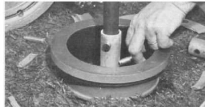
5. Assemblez la tige supérieure et le nouvel accouplement de tige de sécurité sur la tige inférieure et fixez-les avec la nouvelle goupille de chape en acier inoxydable et la nouvelle goupille fendue fournie avec l'accouplement de tige de sécurité.
