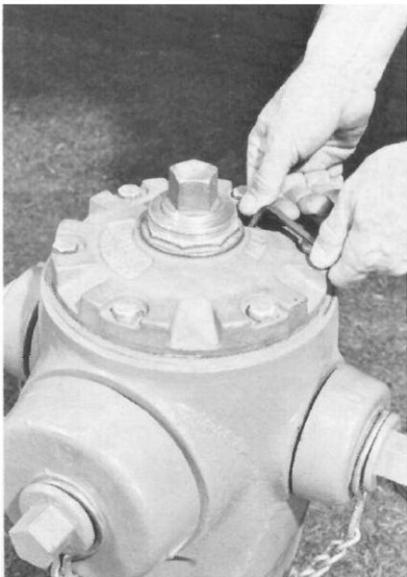
2. Retirez le bouchon de remplissage d'huile et vérifiez le niveau d'huile. L'huile doit être au niveau de l'orifice du bouchon de remplissage d'huile.
