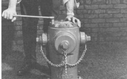
1. Retirez le capuchon étanche, l'écrou de maintien, la rondelle anti-friction et l'écrou de fonctionnement. Lubrifiez le manchon en laiton et faites-le glisser sur l'extrémité de la tige filetée pour éviter d'endommager le joint torique. Déboulonnez et retirez le boîtier. Retirez les boulons de la bride de sécurité et la bride de sécurité.
