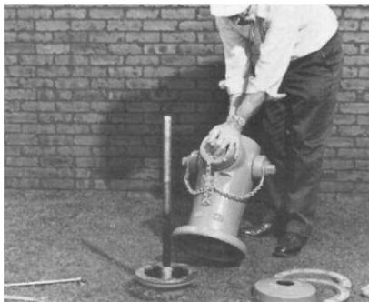
2. Retirez le canon supérieur. Retirez la tige supérieure et l'accouplement de tige de la tige inférieure. Faites glisser l'extrémité fendue de la clé sur la tige inférieure. Alignez les trous de la clé et de la tige et fixez la clé à la tige avec un axe de chape. Abaissez le bras de support sur la bride du cylindre inférieur et serrez la vis moletée pour maintenir la vanne principale en position fermée. Fermez l'eau au robinet-vanne.
