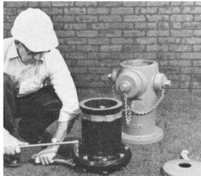
5. Fixez le baril d'extension au baril inférieur avec des moitiés de bride solides (sans rainure) et des boulons, en s'assurant que le joint de bride est en place.
