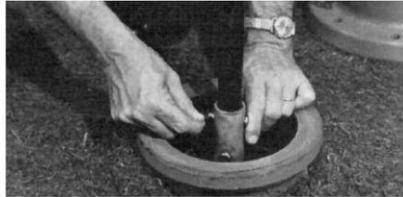
4. Placer la tige d'extension et le couplage d'extension sur la tige inférieure et les retenir avec une goupille de chape et une goupille fendue en acier inoxydable.
