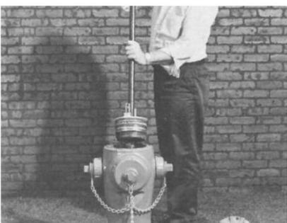
3. Soulevez la clé, les tiges supérieure et inférieure, l'assemblage de la vanne principale et l'anneau de siège du barillet de la bouche d'incendie en tant qu'unité.
