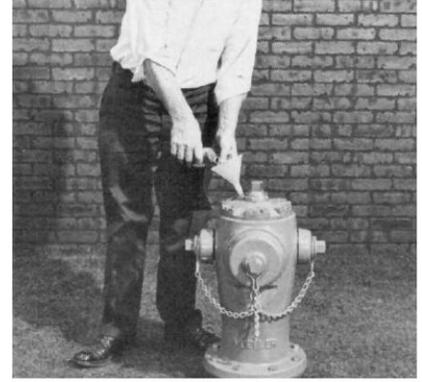
7. Fixez le manchon en laiton à la tige supérieure et lubrifiez l'extérieur pour protéger les joints toriques contre les dommages au filetage. Placez le boîtier sur le canon supérieur et serrez les boulons. Retirez le manchon en laiton, réassemblez l'écrou de fonctionnement, la rondelle anti-friction et l'écrou de maintien.\* Assurez-vous que les joints toriques sont en bon état au niveau de l'épaulement fileté à l'extérieur de l'écrou de maintien et à l'intérieur où le contact est établi
