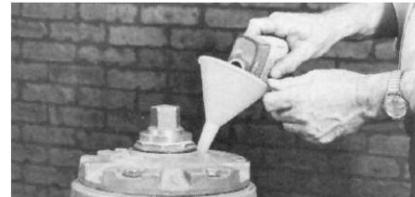
8. Fixez le manchon en laiton à la tige supérieure et lubrifiez l'extérieur pour protéger les joints toriques contre les dommages au filetage. Boulonnez le boîtier sur le canon supérieur et retirez le manchon en laiton.
