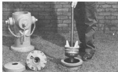
5. Abaissez l'assemblage de la vanne principale et vissez soigneusement à la main la bague de siège dans la base de la bouche d'incendie. Soulevez la soupape principale en laissant environ 1/2 po de jeu entre la soupape principale et le siège. Abaissez le bras de support sur la bride du canon inférieur et serrez la vis moletée.
