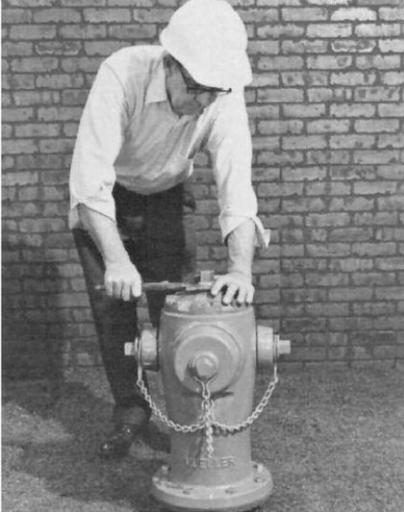
1. Retirez le capuchon étanche, l'écrou de retenue, la rondelle anti-friction et l'écrou de fonctionnement de la bouche d'incendie. Lubrifiez l'extérieur du manchon en laiton et faites-le glisser sur la tige filetée pour éviter d'endommager le joint torique. Dévissez et retirez le boîtier. Retirez le manchon en laiton.
