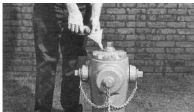
8. Fixez le manchon en laiton à la tige supérieure et lubrifiez l'extérieur pour protéger les joints toriques contre les dommages au filetage. Placez le boîtier sur le canon supérieur et serrez les boulons. Retirez le manchon en laiton.
