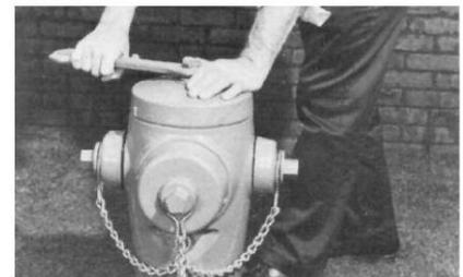
9. Dévissez légèrement un capuchon de buse de tuyau pour purger l'air. Ouvrez complètement la bouche d'incendie. Serrez le capuchon de la buse du tuyau lorsque l'eau commence à couler et vérifiez que tous les joints ne fuient pas. Tournez l'écrou de fonctionnement en position complètement fermée et retirez le capuchon de la buse du tuyau pour permettre au baril de se vider. Remplacez le capuchon de la buse du tuyau.
