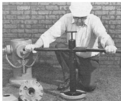
6. Serrez la vanne principale à 200 lb-pi. Ouvrez l'eau au robinet-vanne et retirez la clé de la tige en retirant l'axe de chape.
