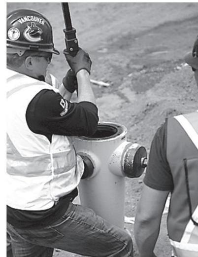
3. À l'aide de la clé de retrait du siège, tournez dans le sens inverse des aiguilles d'une montre pour retirer la tige inférieure et l'ensemble siège.
