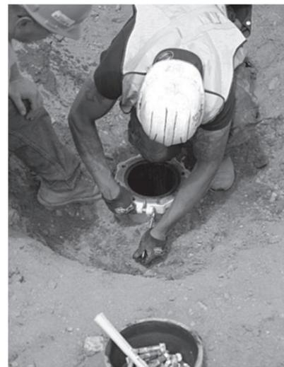
4. Dévissez les boulons et les écrous et retirez le canon supérieur, la bride de circulation et le joint du canon. (Ne jetez pas les écrous et les boulons ; ils sont nécessaires pour l'étape 8).
