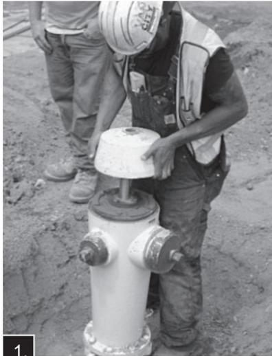
1. Pour retirer le chapeau, localisez les goupilles du chapeau qui se trouvent directement au-dessus des capuchons des flexibles. À l'aide d'un marteau et d'un poinçon, enfoncez les broches dans le boîtier. (Ne jetez pas les goupilles du capot ; elles sont nécessaires pour l'assemblage final du capot à l'étape 13).
