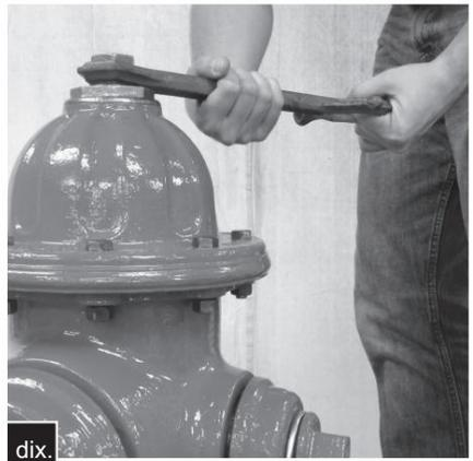
Tournez l'écrou de commande dans le sens de la fermeture pour vous assurer que la vanne principale est bien fermée, puis tournez dans le sens de l'ouverture d'environ 1/4 de tour pour relâcher la tension sur le mécanisme de commande.
