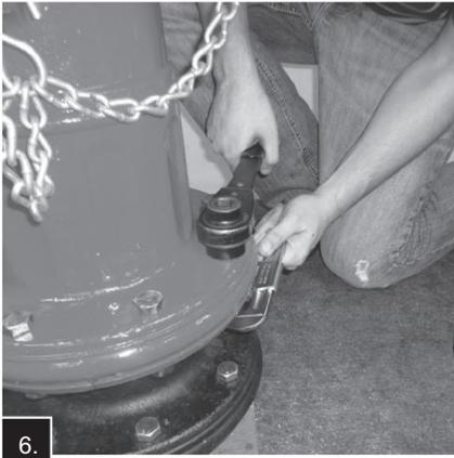
Fixez le canon supérieur avec les moitiés de bride de circulation (avec le biseau sur le bord extérieur vers le bas) et les boulons ; en s'assurant que le joint torique Traffic Flange\* est dans la rainure du canon supérieur. Serrez les boulons à 60 pi-lb.
