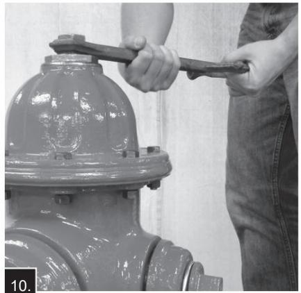
10. Tournez l'écrou de commande dans le sens de la fermeture pour vous assurer que la vanne principale est bien fermée, puis tournez dans le sens de l'ouverture d'environ 1/4 de tour pour relâcher la tension sur le mécanisme de commande.
