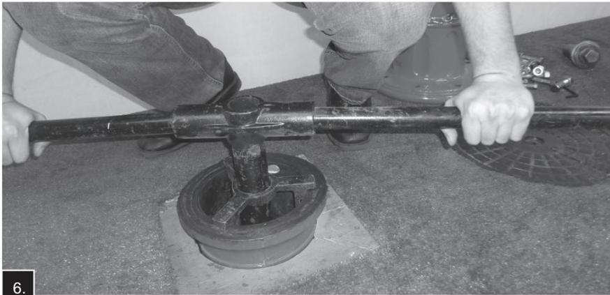
6. Serrez la vanne principale à 100-150 lb-pi. Ouvrez l'eau au robinet-vanne et retirez la clé de la tige en retirant l'axe de chapeau.
