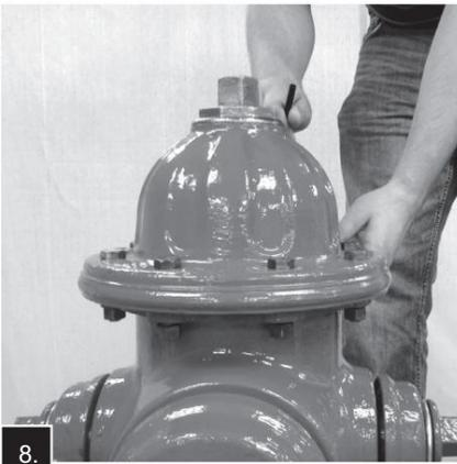
8. Retirez le bouchon de remplissage d'huile sur le côté du capot. Versez le lubrifiant MUELLER Hydrant dans le réservoir d'huile jusqu'à ce qu'il soit au niveau de l'orifice du bouchon de remplissage d'huile. Remplacez le bouchon de remplissage d'huile (voir la section Lubrification à la page 8).
