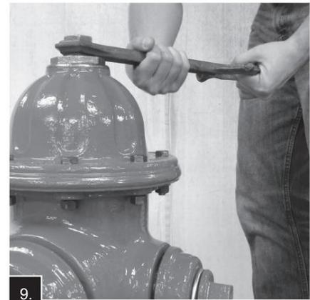
9. Tourner l'écrou de commande dans le sens de la fermeture pour s'assurer que la vanne principale est fermée fermement, puis tournez dans le sens de l'ouverture d'environ 1/4 de tour pour relâcher la tension sur le mécanisme de fonctionnement.
