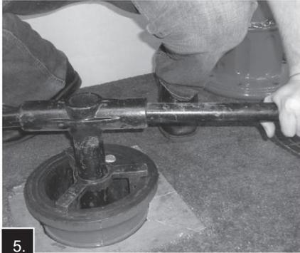
5. Serrez la vanne principale à 100-150 lb-pi. Ouvrez l'eau au robinet-vanne et retirez la clé de la tige en retirant l'axe de chape.
