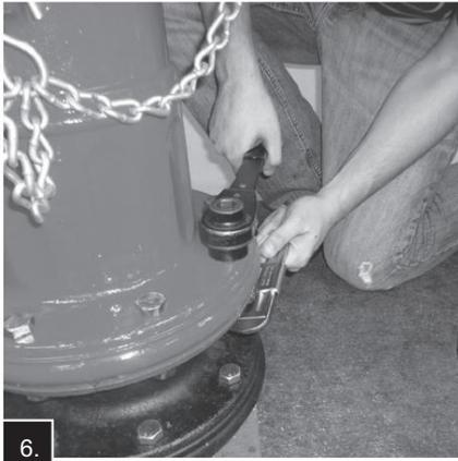
6. Fixez le canon supérieur avec les moitiés de bride de circulation (avec le biseau sur le bord extérieur vers le bas) et les boulons ; en s'assurant que le joint torique Traffic Flange\* est dans la rainure du canon supérieur. Serrez les boulons à 60 pi-lb.
