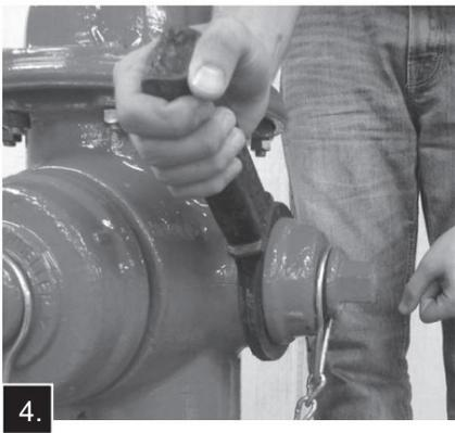
4. Installez le joint torique de la buse sur le côté entrée de la buse. Vissez la nouvelle buse dans
