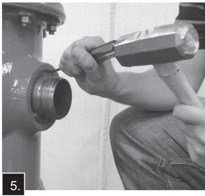
5. Retirez le capuchon de buse et la clé de buse A-316. Placez le verrou de buse (pièce 143137) dans le sens de la longueur dans la fente formée par les pattes d'entraînement de buse et l'alésage du canon. Enfoncez le verrouillage de la buse place en frappant plusieurs fois l'outil d'installation de verrouillage de buse (pièce 143132) avec un gros marteau en laiton.
