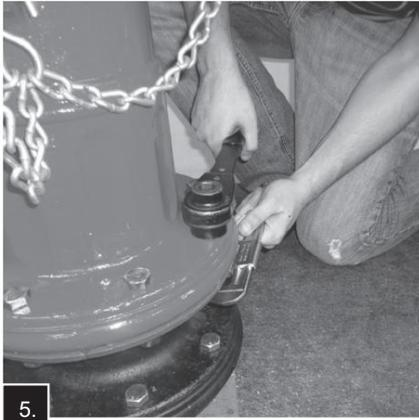
5. Fixez le canon supérieur avec de nouvelles moitiés de bride de circulation (avec le biseau sur le bord extérieur vers le bas) et des boulons ; en s'assurant que le joint torique Traffic Flange\* est dans la rainure du canon supérieur. Serrez les boulons à 60 pi-lb.
