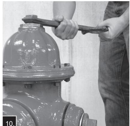
10. Tourner l'écrou de commande dans le sens de la fermeture pour s'assurer que la vanne principale est fermée fermement, puis tournez dans le sens de l'ouverture d'environ 1/4 de tour pour relâcher la tension sur le mécanisme de fonctionnement.
