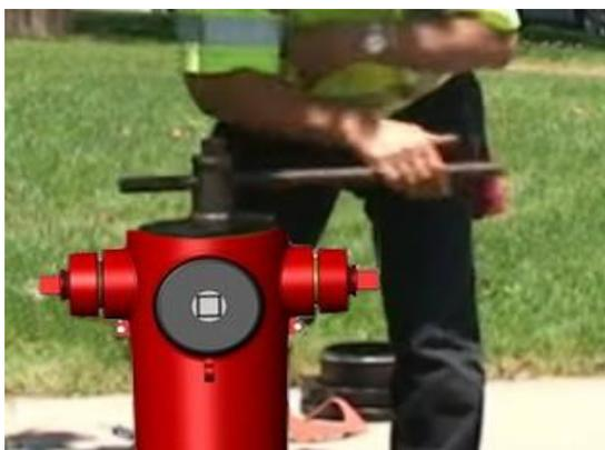
6. Une fois le siège complètement dévissé soulever le mécanisme de quelques pouces et tirant vers le haut la tige en acier. Le siège devrait se libérer de son socle. Retirer la barre d'acier de la clé Retirer la clé de service en acier.
