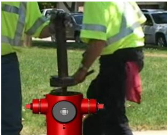
7. Installer une guénille sur les filets de la tige supérieure afin de ne pas vous salir de graisse
