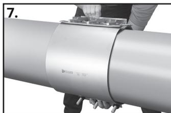
6. Enroulez les sections autour du tuyau en tenant la barre de levage et les goujons d'une section et en faisant glisser l'extrémité réceptrice de la dernière section sous le tuyau.
