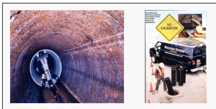
Figure 50 – Exemple de tubage segmenté
