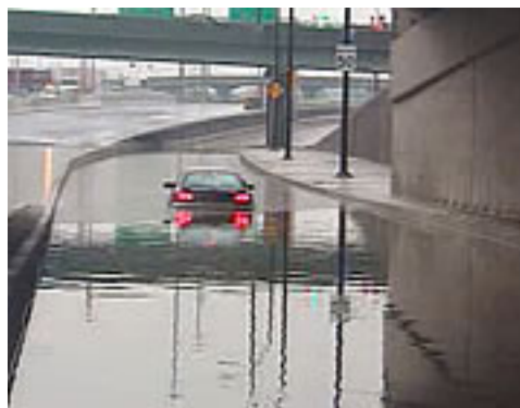
Figure 2 – Inondation d'une autoroute en raison d'un manque de capacité de l'égout
