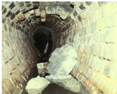
Figure 7 – Exemple d'obstruction
