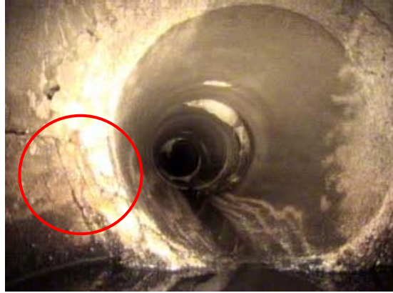
Figure 61 – (Photo 1) Armature visible de 8 h à 9 h
