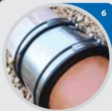
Mesurer la largeur du raccord et tracer un repère, sur les deux tubes à raccorder, correspondant à la moitié de la largeur du raccord.
