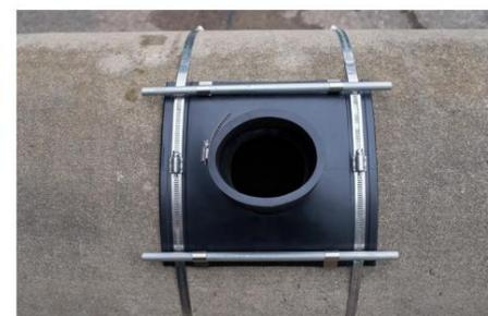
5. Les barres doivent être centrées et positionnées en chevauchant le jeu initial de pinces.
