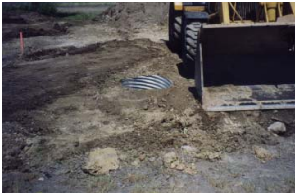
Figure 3.16 - Essai 1.1.B : Fin du remblayage de la tranchée B - TTAOG-36 Ville de Longueuil
