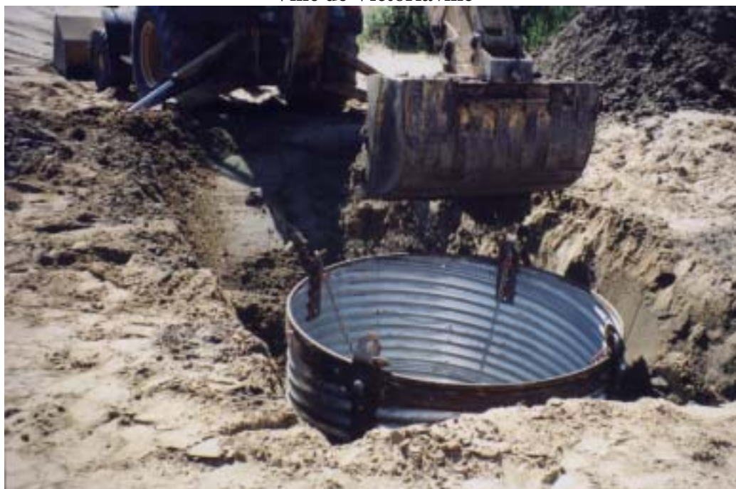
Figure 3.25 - Essai 2.3.A : Mise en place du TTAOG-60 dans la tranchée A Ville de Victoriaville
