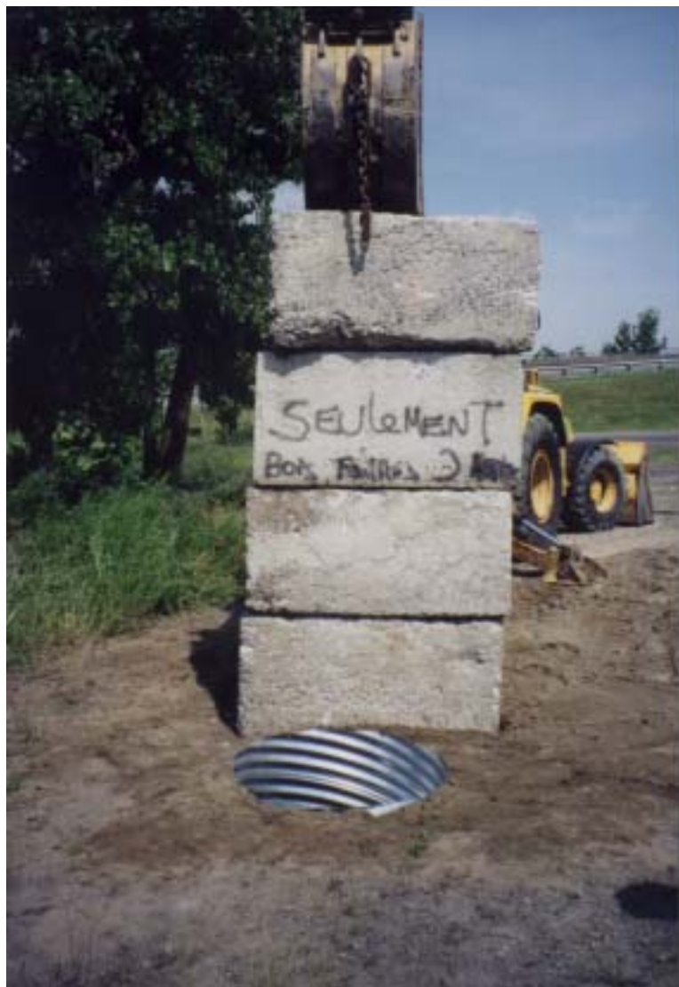
Figure 3.13 - Essai 1.1.A : Surcharge avec 4 blocs de béton posés sur le sable remblayé près du TTAOG-36 - 19 juin 2001
