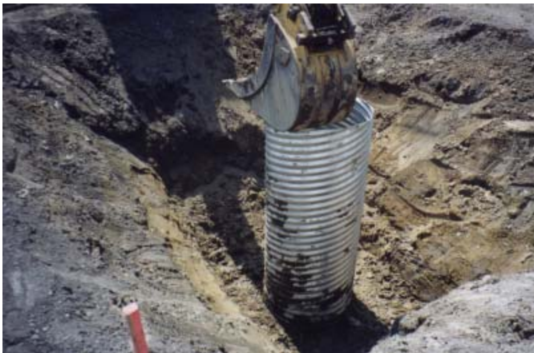
Figure 3.14 - Essai 1.1.B : Excavation de la tranchée B et mise en place du TTAOG-36 en fond de tranchée - Ville de Longueuil- 19 juin 2001
