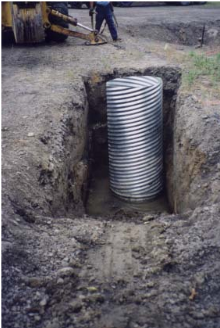
Figure 3.11 - Essai 1.1.A : Installation du TTAOG-36 dans la tranchée d'essai – 19 juin 2001
