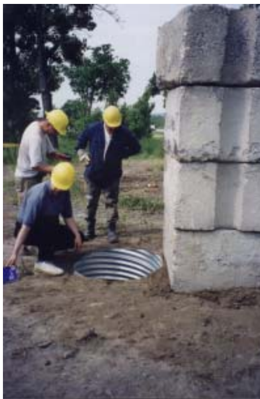
Figure 3.17 - Essai 1.1.B : Surcharge par des blocs posés près du TTAOG-36 Ville de Longueuil
