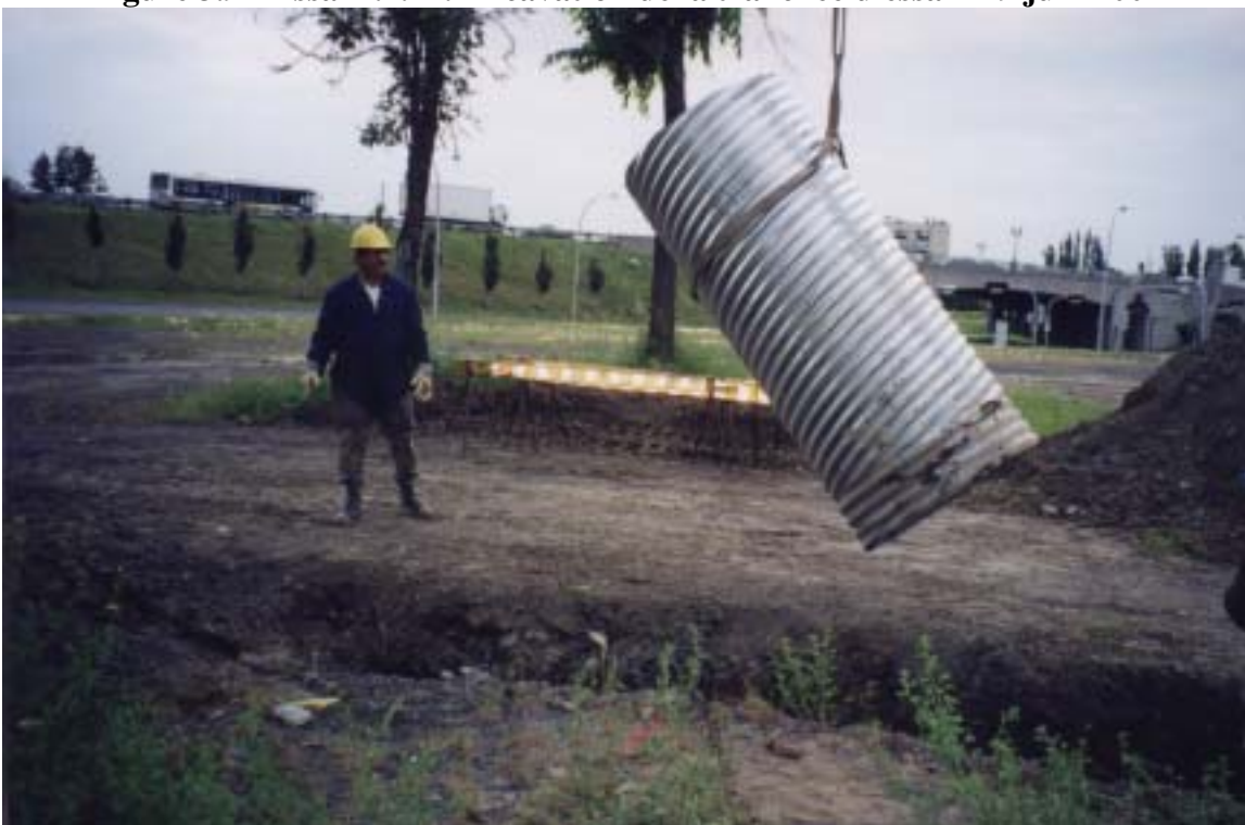
Figure 3.10 - Essai 1.1.A : Transport du TTAOG dans la tranchée d'essai - 19 juin 2001
