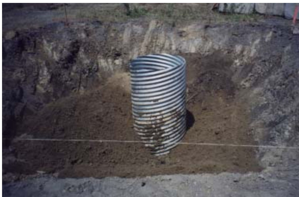
Figure 3.15 - Essai 1.1.B : Remblayage de la tranchée B par du sable sur 1,8 m et par l'argile brune sur 0,5 m - TTAOG-36 - Ville de Longueuil - 19 juin 2001
