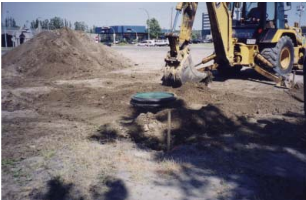
Figure 3.20 - Essai 1.2.B : Remplissage de la tranchée B par du sable et du remblai - PEHD-36 Ville de Longueuil
