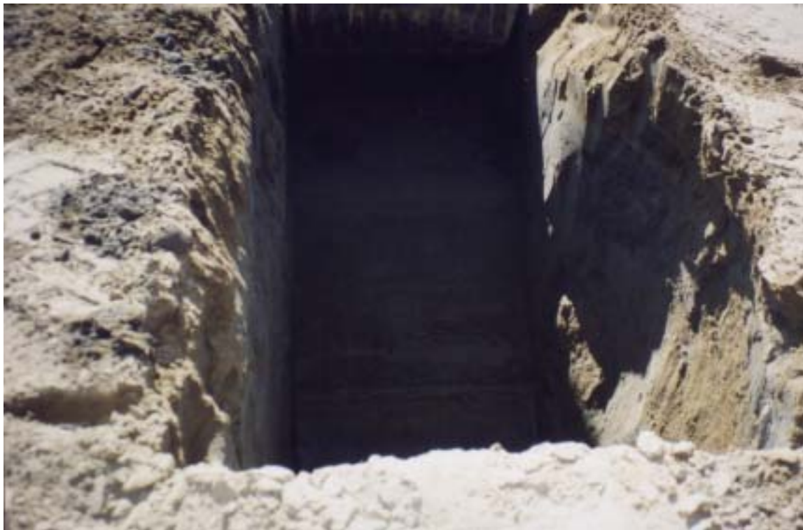
Figure 3.9 - Essai 1.1.A : Excavation de la tranchée d'essai - 19 juin 2001
