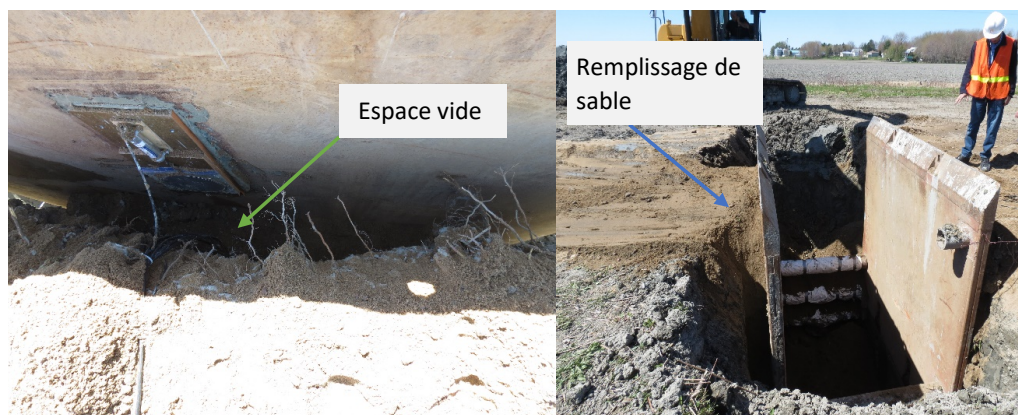
Figure 34. Boîtes de tranchée installées et ajout de sable pour assurer un contact entre les parois de l'excavation et la boîte.
