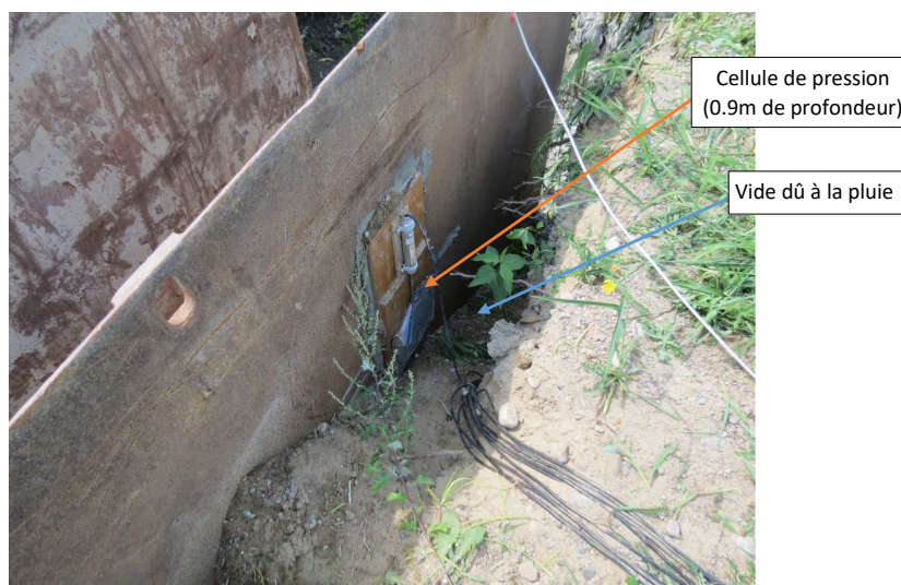
Figure 64. Sable lavé par les pluies en surface et cellule de charge apparente.
