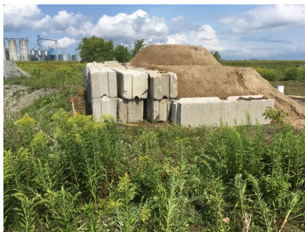
Figure 31. Arrangement du sable et des blocs de béton sur le bord de la tranchée A-2.
