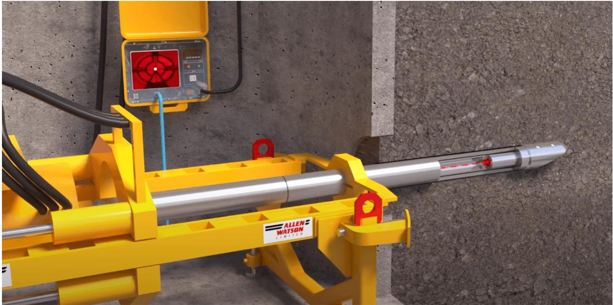
L'une des caractéristiques déterminantes du forage par poussée est sa double action de vérinage et de forage. Une tarière avec une tête de coupe est placée à l'intérieur d'un boîtier en acier et posée contre la paroi d'une fosse d'entrée. La tête de coupe tourne, forant le sol et enlevant les déblais, tandis qu'une plate-forme de levage pousse ou « pousse » le tubage et la tarière vers la fosse de sortie.
